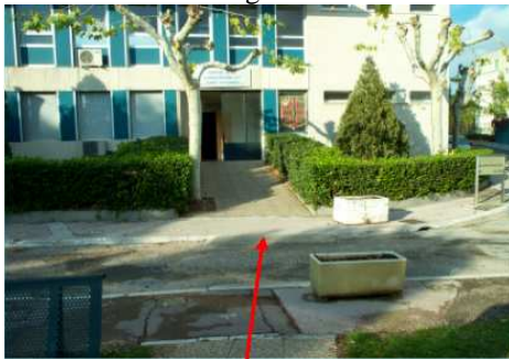
Pente d'accès Centre de Consultations Externes REVIL
